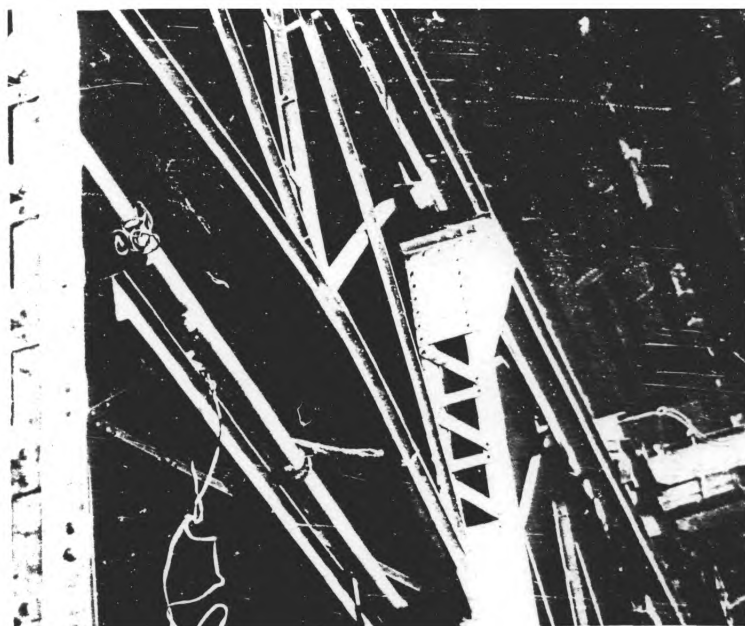
Рис. 6 Деформация вертикальной связи колонн из плоскости.
