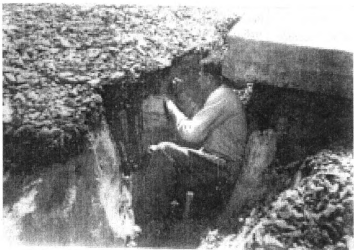
Рис.1. Сборные плиты с открытыми стыками, размер 2,5 \times 4 \times 0,25 м на сплошном обратном фильтре. Глубина размыва грунта в подплитной области около 80 см. Высота волн 3,2 м, расчетная 3,0 м.
