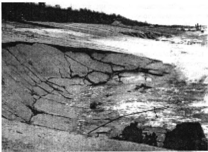
Рис.2. Монолитные ж/б плиты 25 \times 25 \times 0,15 м с уплотнением стыков опалубкой, фильтр сплошной двухслойный. Высота волн 3,2 м, расчетная 3,0 м, навал груженной баржи.
