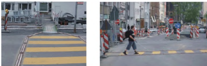
Рисунок 61– Пример обустройства временного пешеходного перехода
