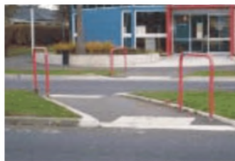
Рисунок 38 – Рекомендуемая форма конструкции и основные параметры пешеходного ограждения (а), пример применения (б)
