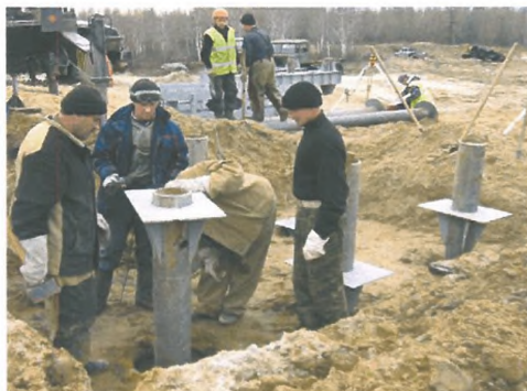
Рис.2.9 - Погрузочно-разгрузочные работы (перемещение нижних балок ростерка); выполнение земляных работ, задание проектной вертикальной отметки, установка опорных столиков и закрепление их к сваям прихваточными сварными швами
