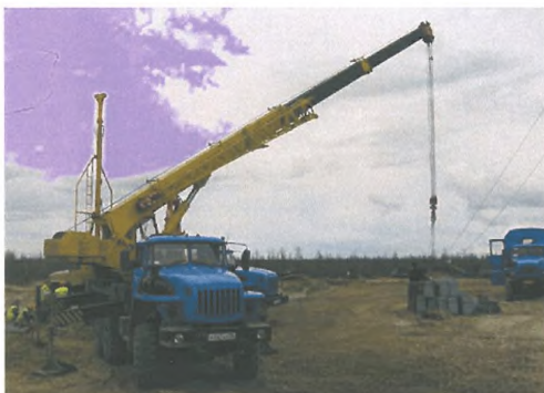
Рис.2.9 - Погрузочно-разгрузочные работы (перемещение нижних балок ростерка); выполнение земляных работ, задание проектной вертикальной отметки, установка опорных столиков и закрепление их к сваям прихваточными сварными швами
