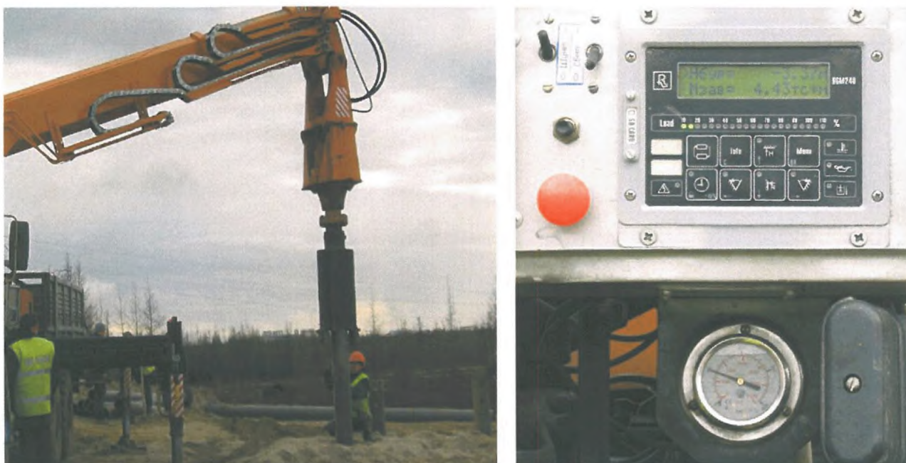
Рис.2.6 - Завинчивание сваи с контролем вертикальности; приборный щиток
