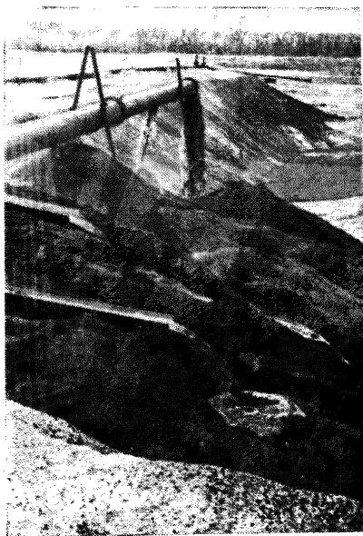
Рис. 1-1. Намыв ограждающей дамбы на отвале Тихвинского завода.
