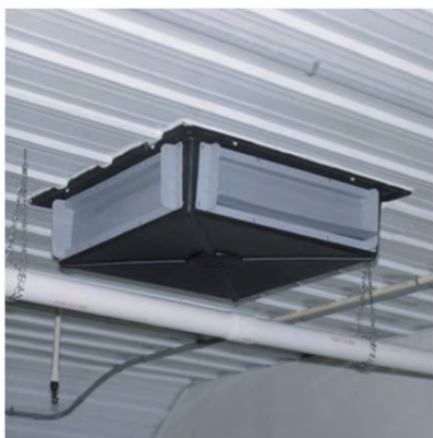
Рисунок 2.27 — Различные типы приточных воздушных клапанов
