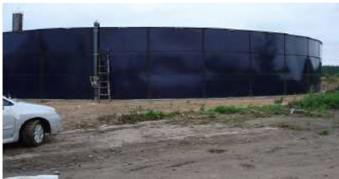
Рисунок 2.59 — Металлическое круглое хранилища (эмалированные стальные листы)
