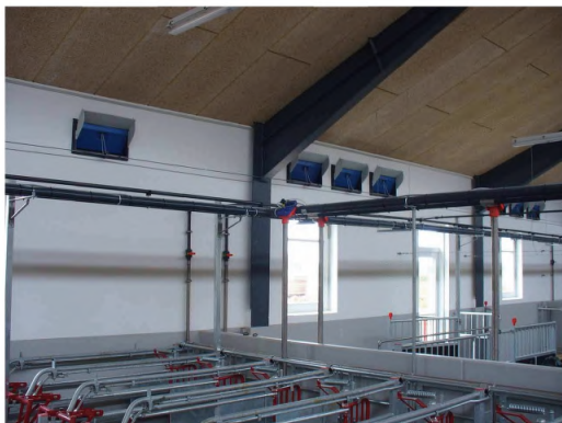
Рисунок 2.28 — Пример системы вентиляции с использованием приточных клапанов
