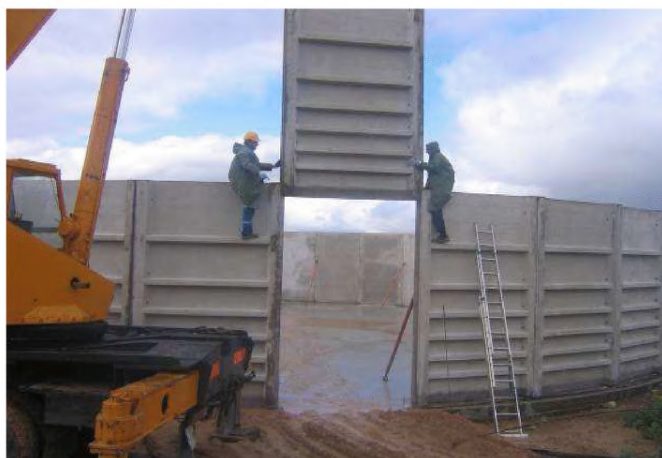
Рисунок 2.58 — Круглое сборное бетонное хранилище
