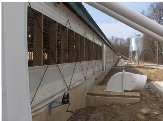
Рисунок 2.23 — Управляемая занавесь позволяет организовать естественную вентиляцию в прохладные часы суток летом
