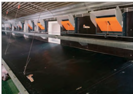
Рисунок 2.47 — Установка оребренных труб в секторе дорастивания
