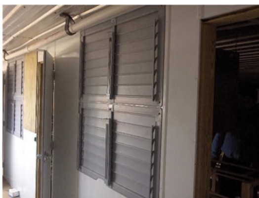
Рисунок 2.27 — Различные типы приточных воздушных клапанов
