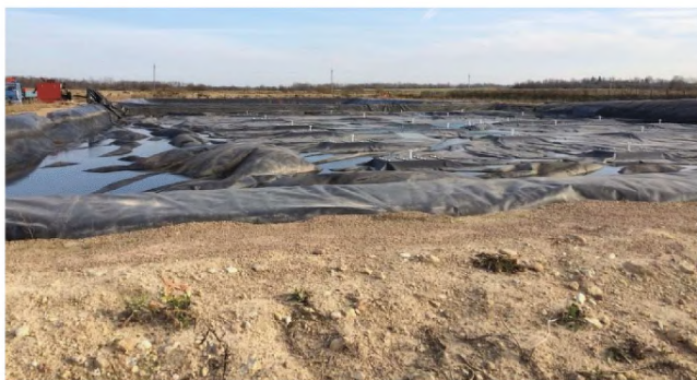
Рисунок 2.56 — Лагуна с пленочным покрытием дна и поверхности навоза для уменьшения выбросов загрязняющих веществ
