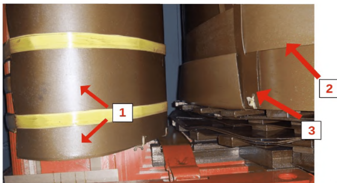
Рисунок 11 – Пример конструкции с барьером по всей высоте обмотки ВН, барьером на боковом ярме и зоны отбора образцов
