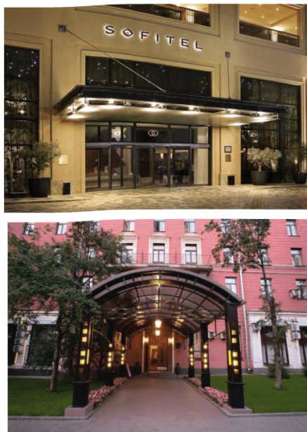
Рисунок 5.18 – Слева – козырек на металлических подвесах, справа – козырек на опорах
